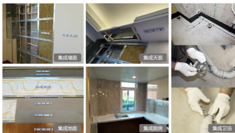
图 A.7.3 集成墙板和装修示意
